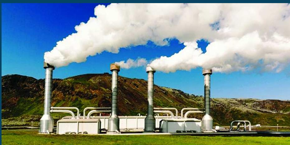
Η γεωθερμική ενέργεια προέρχεται από το εσωτερικό της γης και ανάλογα με τη θερμοκρασία των ρευστών που ανέρχονται στην επιφάνεια χαρακτηρίζεται ως υψηλής ενθαλπίας (για θερμοκρασίες πάνω από 150°C), μέσης ενθαλπίας (για θερμοκρασίες 100-150°C), και χαμηλής ενθαλπίας (για
