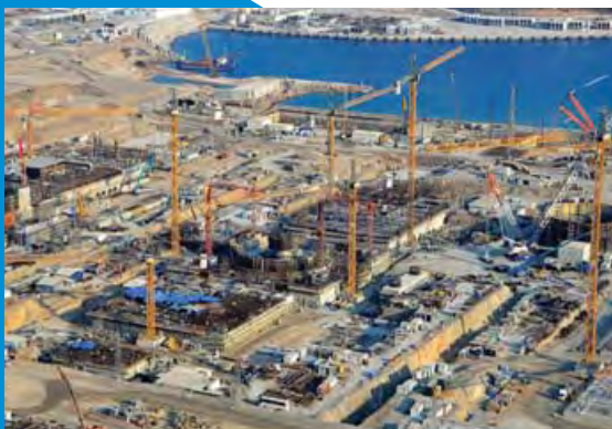
Εικόνα 7: Ο υπό κατασκευή πυρηνικός σταθμός στο Ακούγιου 20
