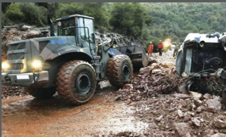
Εικόνα 2: Εκσκαφέας του Μηχανικού επιχειρεί στη Ν. Πέραμο Αττικής μετά τις πλημμύρες του 2017
