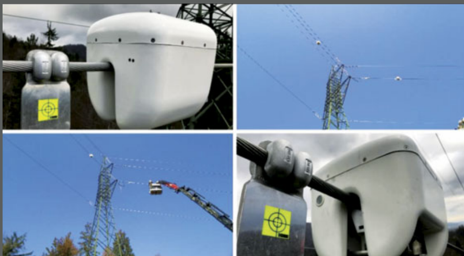
Εικόνα 3: Εγκατάσταση συσκευών OLTM στην γραμμή μεταφοράς Kleče - Logatec
